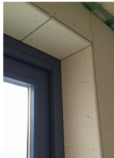
Figuur 2-2, kozijn met fermacell dagkant
