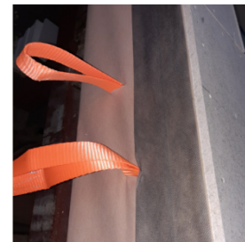
Figuur 2-1, extra bescherming bovenzijde element
